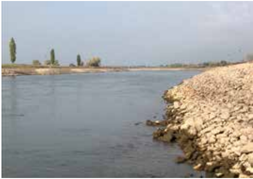
Figuur 1 Een natuurlijke rivier zou bij lage waterstanden vlechten en daarmee voor veel soorten eenvoudiger zijn te passeren door te waden of klein stukje zwemmen. Veel rivieren hebben echter kribben en stenige oevers waardoor ook bij laag water de rivier een barrière blijft.
